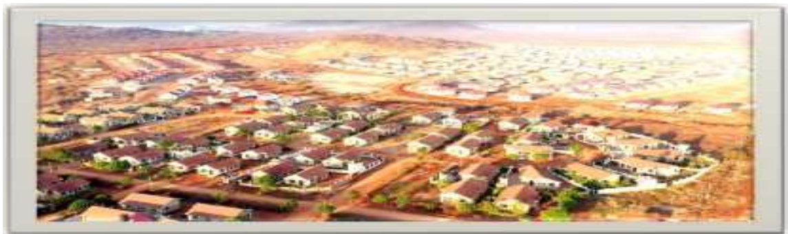
Ujenzi wa nyumba za Iyumbu-Dodoma
